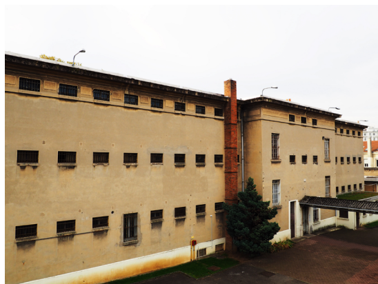
Vue extérieure du bâtiment cellulaire, 2017 © Mémorial Montluc ONACVG
